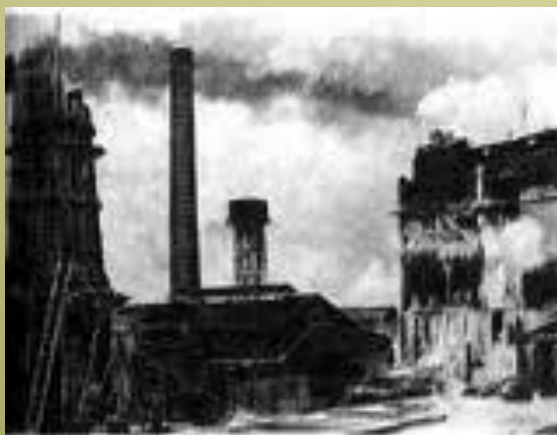
Будівництво доменної печі на металургійному заводі в Макіївці
