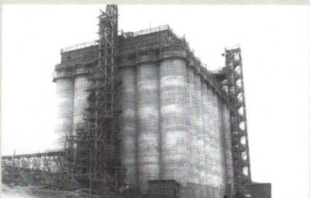
Загальний вигляд будівництва великого елеватора. Херсон. 1932-1933 рр.
